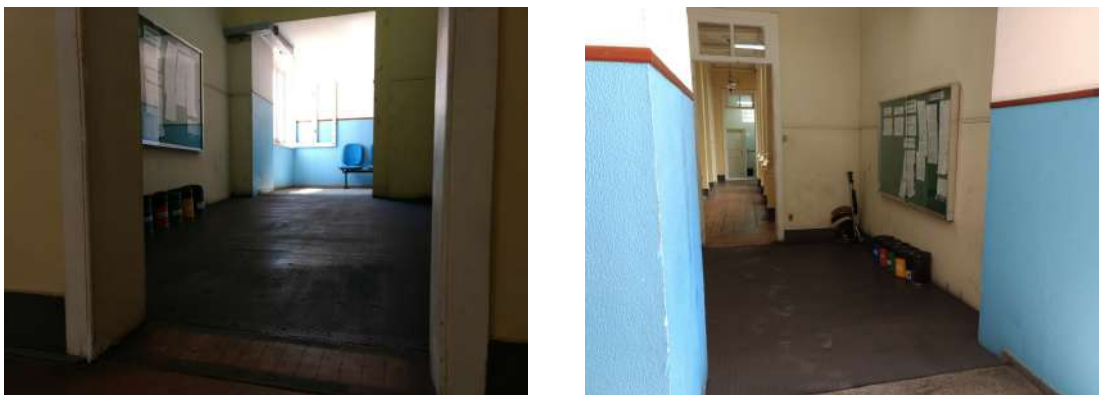
Figura 4: Instalação de rampas entre os ambientes desnivelados.
