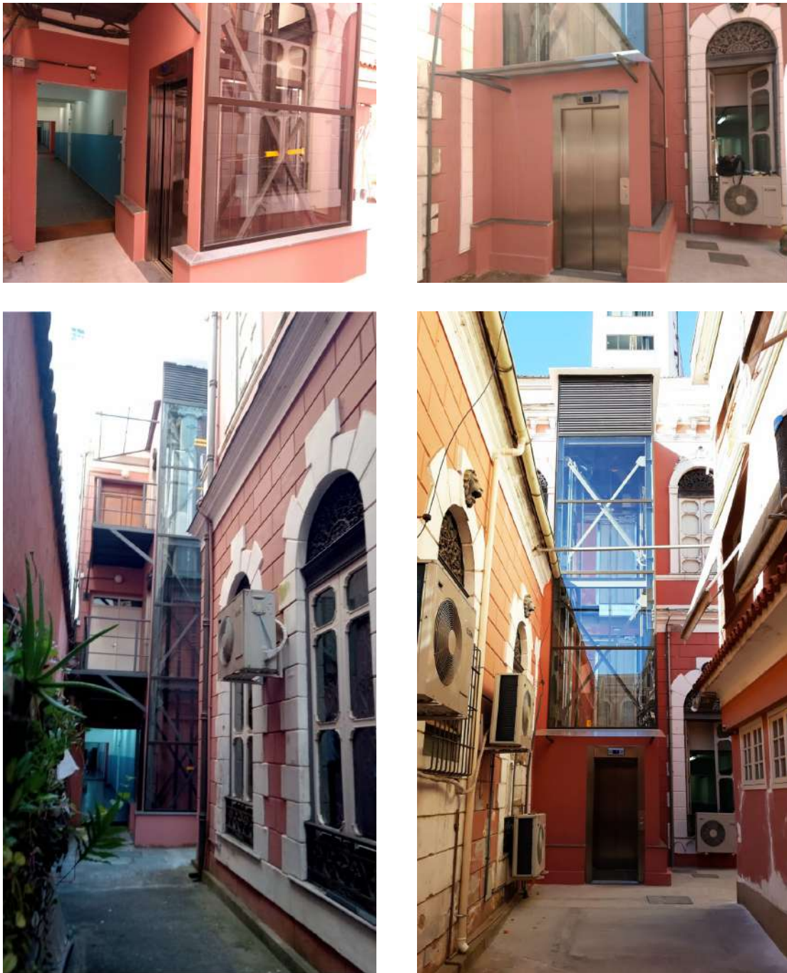
Figura 6: Elevadores de acesso aos três andares dos blocos da Uned.
