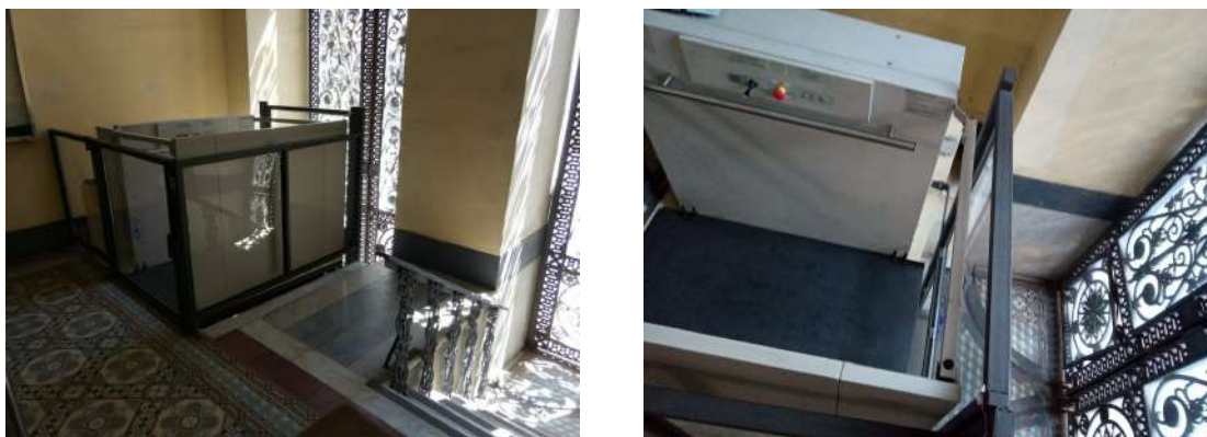
Figura 5: Plataforma elevatória para acessar a entrada principal da Uned.
